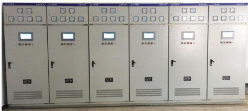
恒流高压直流控制柜
