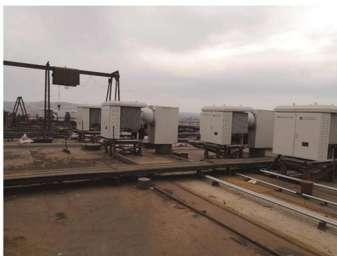
静电除尘运行案例四
